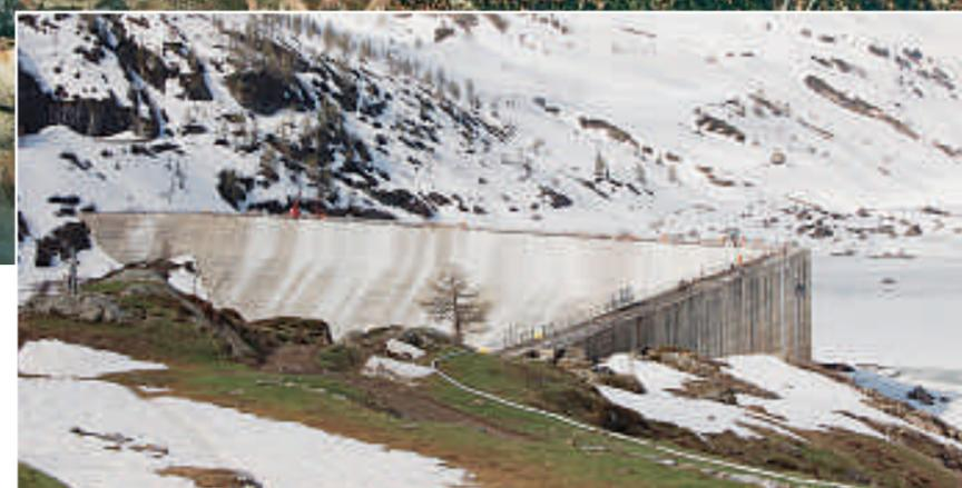
Le barrage de Salanfe, réalisé dans les années 1950, mesure 52 m de haut pour une épaisseur de 40 m à la base et une longueur au couronnement de 600 m. Les travaux d'assainissement consiste à décompresser le béton suite à l'enlèvement de tranches verticales de 11 à 15 mm par sciage. Le principal défi du chantier était de faire des coupes d'une surface allant jusqu'à 240 m<sup>2</sup> d'un seul trait de scie.
