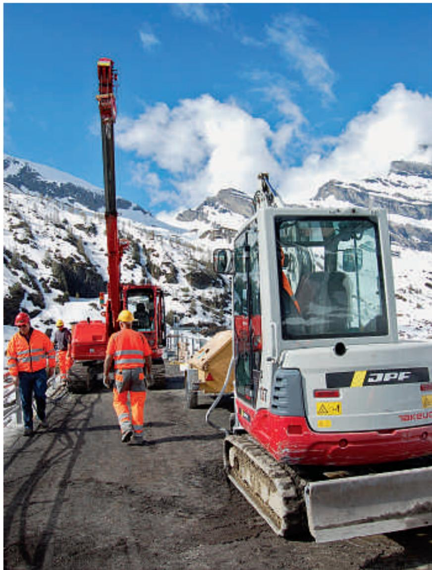
Le couronnement du barrage ne mesure que 5 m de large. Sur cette étroite plateforme, ouvriers, autogrupe et machine de sciage évoluent dans un jeu d'attention, d'habileté et de souplesse pour jongler d'un trait de scie à l'autre.
